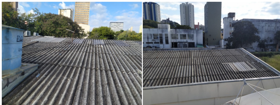
Figura 1 Fotos da cobertura a ser retirada
