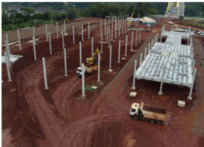
Obras da Perimetral em andamento. Foto: DER-PR
