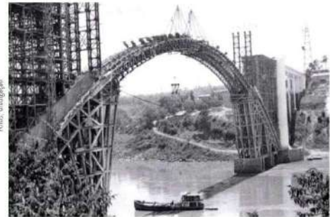
Somente para o arco de sustentação da obra foi montada uma estrutura de aço de 1.200 toneladas
