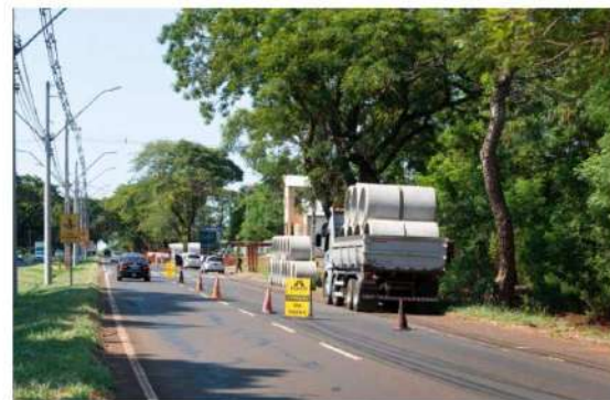
Trecho com interdição de meia pista na Tancredo Neves para as obras da ciclovia 9,1 milhões. A execução, tem prazo estimado de 18 meses. Ao final, as três fases somarão 6,8 km de ciclovias. (JIE)
