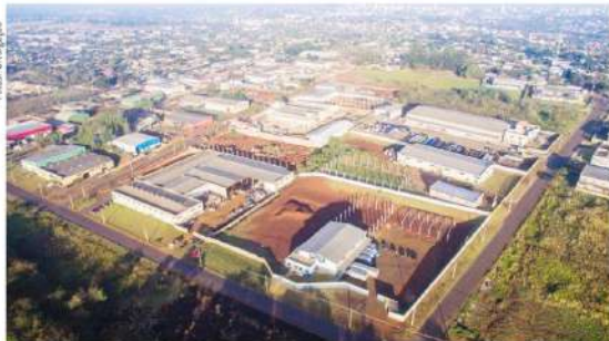
Distrito Industrial de Foz do Iguaçu
