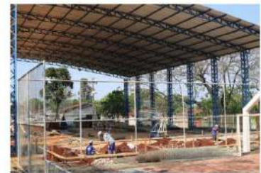
A obra foi um pedido dos moradores da região Norte, durante o Orçamento Participativo 2019
