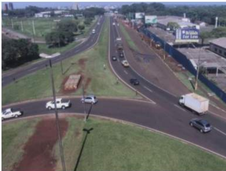
Fechamento da rotatória do CTG Charrua causou muitos transtornos a comunidade
