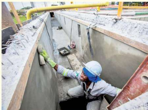
Funcionários trabalham na rede de esgoto de Foz do Iguaçu
