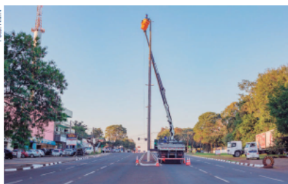
Empresa que está instalando novo sistema de luminárias em Foz tem 10 dias para apresentar certificação das lâmpadas
