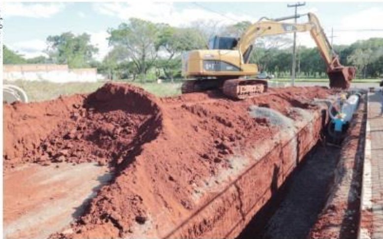
Obras de drenagem também ocorrerão em outros bairros da cidade
