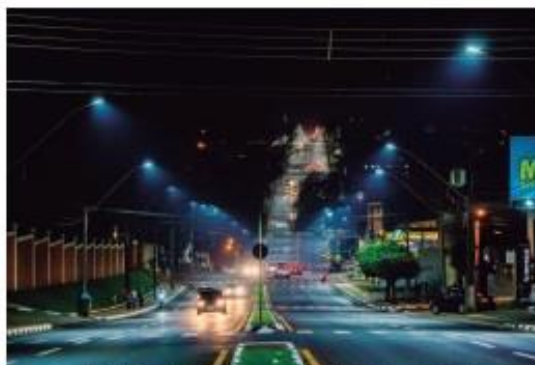
O contrato de R$ 10,3 milhões prevê a instalação de 6.089 luminárias de LED nas principais vias da cidade
