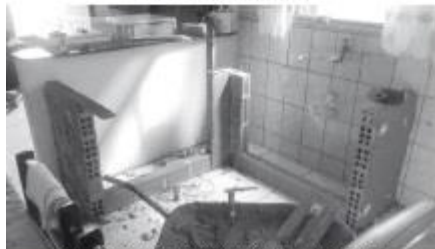
Consejo de perder dinheiro, morador do Jardim São Luiz construiu um pia de concreto
