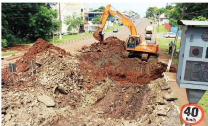
Obra da Ponte sobre o Rio Boicy, localizada na Avenida República Argentina, foi alvo de denúncia na Operação Pecúlio
