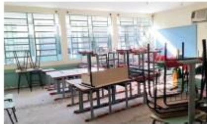
Salas estão interditadas por conta da paralisação das obras
