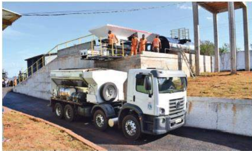
Investimentos da prefeitura pretendem fazer frente à grande demanda de serviços de pavimentação
