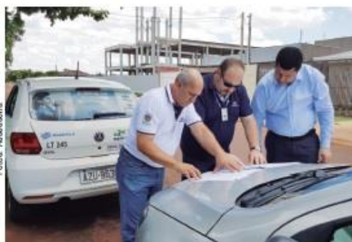
Rogério Quadros e Nilton Perez vistoriam as obras
