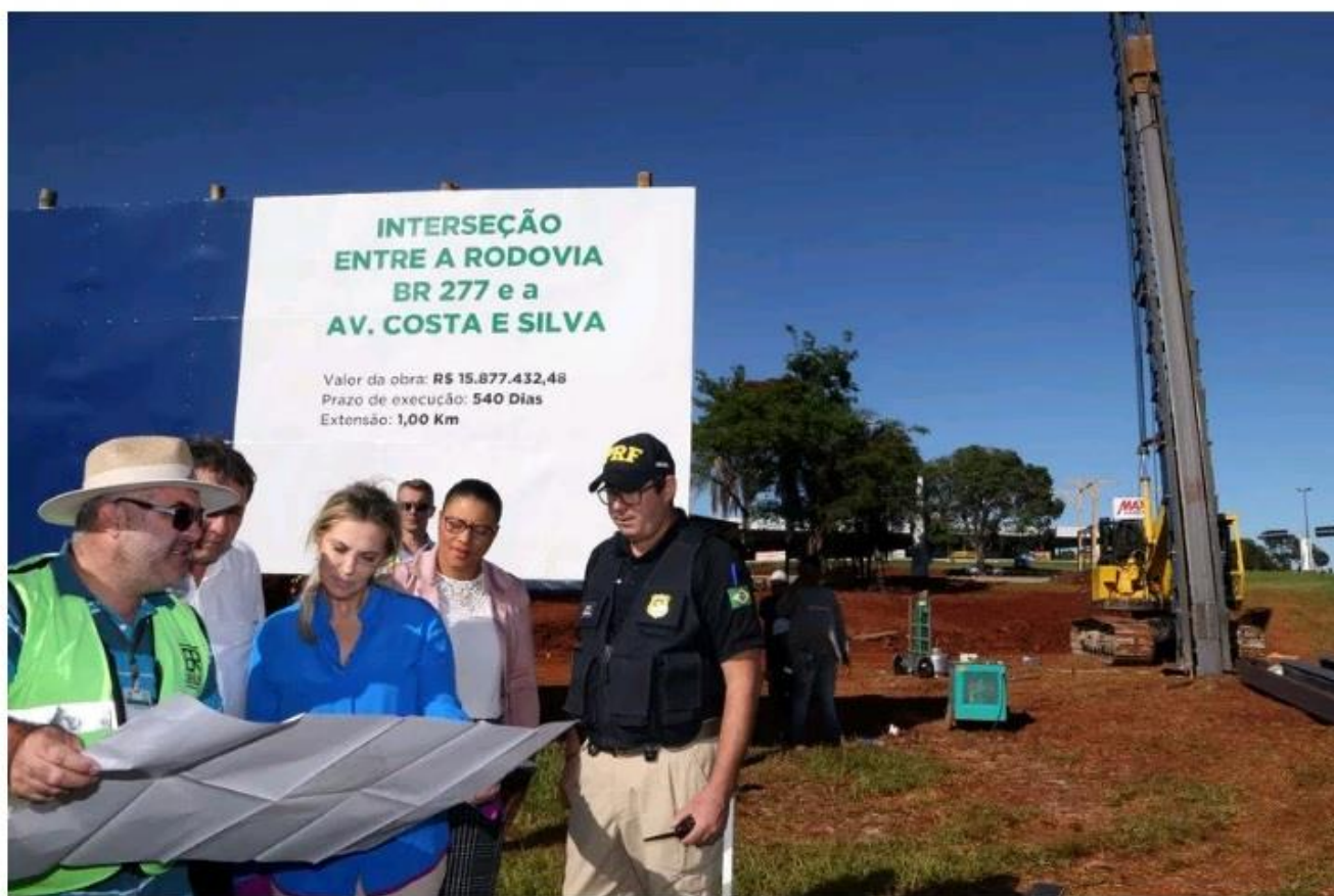
Governadora Cida Borghetti vistoria as obras do viaduto da Avenida Costa e Silva, em Foz do Iguaçu. – Foz do Iguaçu, 09/11/2018 – Foto: Orlando Kissner/ANPr
