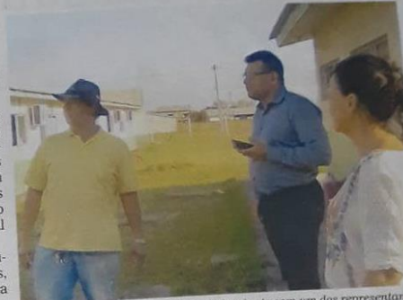
Vereador João Miranda fiscaliza a obra junto com um dos representantes da empresa que está trabalhando na revitalização do Centro de Convivência. Ao lado uma moradora que também acompanhou a visita
