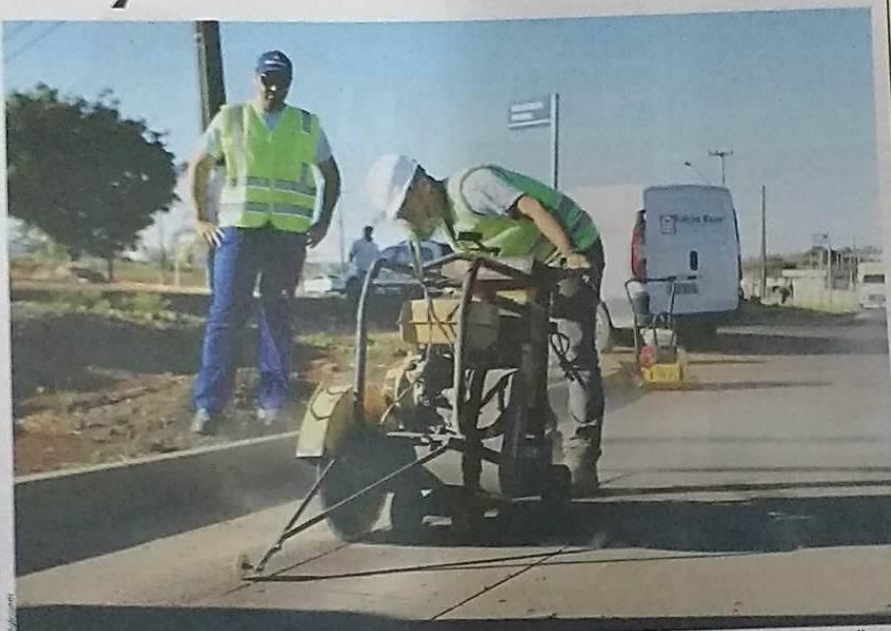
O projeto está em fase de implementação e o Município está licitando equipamentos que serão necessários para a realização dos primeiros serviços
