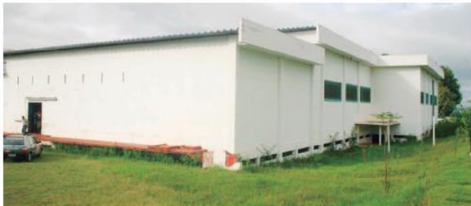
Usina de asfalto será instalada no antigo abatedouro, na Gleba Guarani
