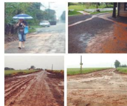
Moradores sofrem com os buracos e com a lama que se forma principalmente quando chove
