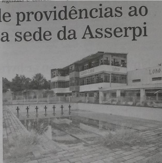
Antiga sede da Asserpi está abandonada já há alguns anos em Foz
