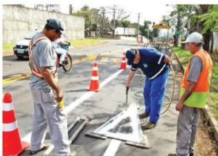
Com a autorização da Câmara, recursos serão liberados de imediato para execução dos serviços de sinalização viária
