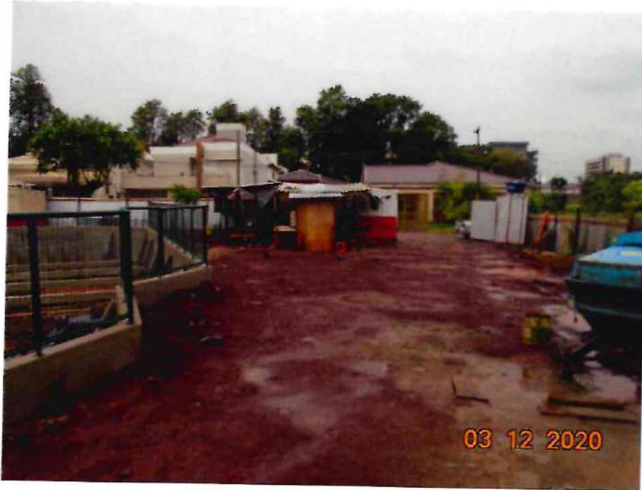
Figura 2 - canteiro de obras
