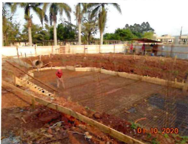
Figura 5 - fundação para execução de radier
