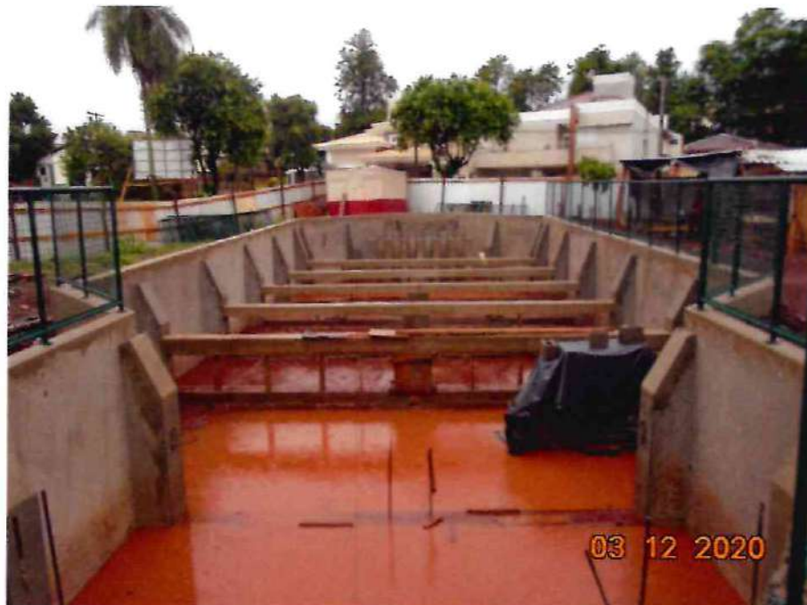
Figura 1 - canteiro de obras
