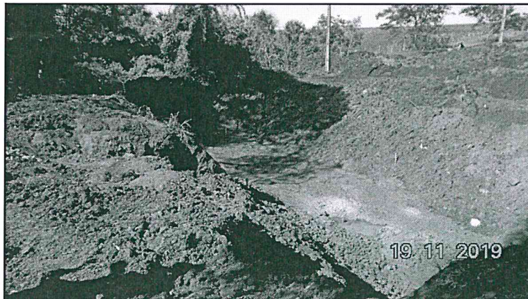
Figura 2 - Corte de solo para instalação da aduela.
