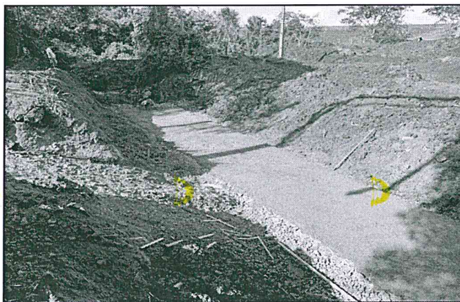
Figura 3 - Regularização de base em concreto.
