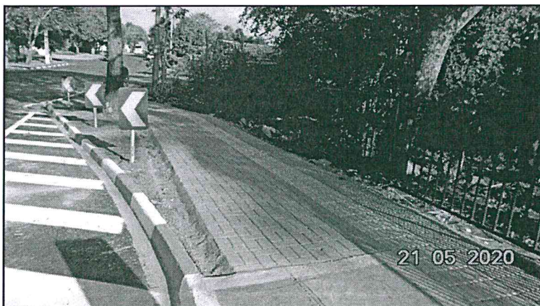
Figura 11 - Passeio em piso intertravado e podotátil.
