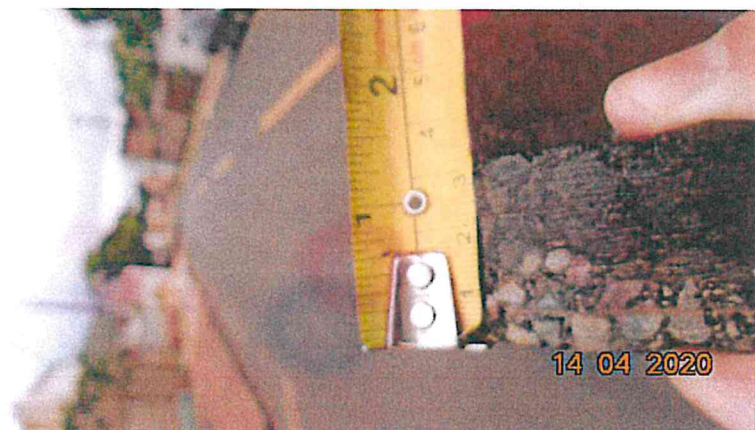
Figura 2 – Corpo de prova nº 1 - Rua dos Cravos
