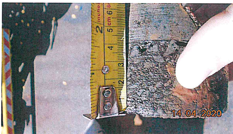
Figura 18 – Corpo de prova nº 17 - Rua Ágata
