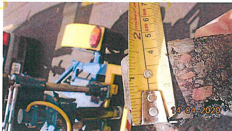
Figura 14 – Corpo de prova nº 13 - Rua Palometa (Reperfilamento e capa)
