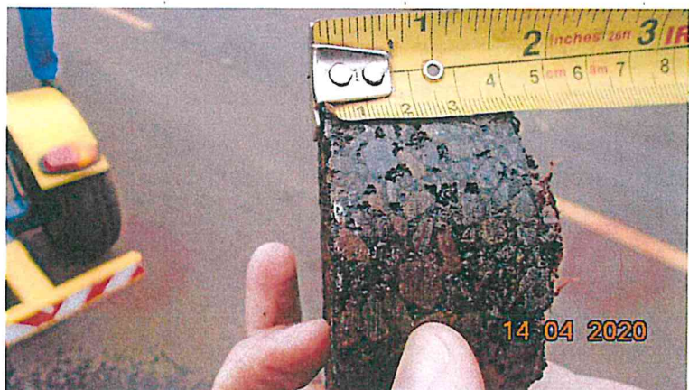
Figura 3 – Corpo de prova nº 2 - Rua dos Cravos
